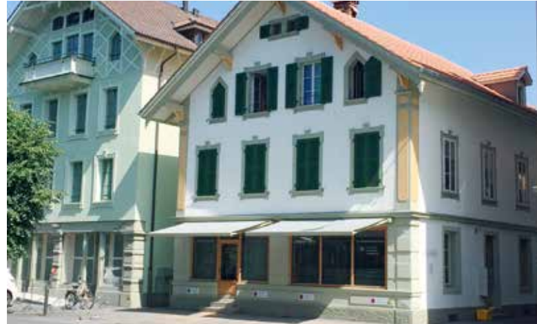
Pilzkontrolle, Allmendstrasse 8, Thun
