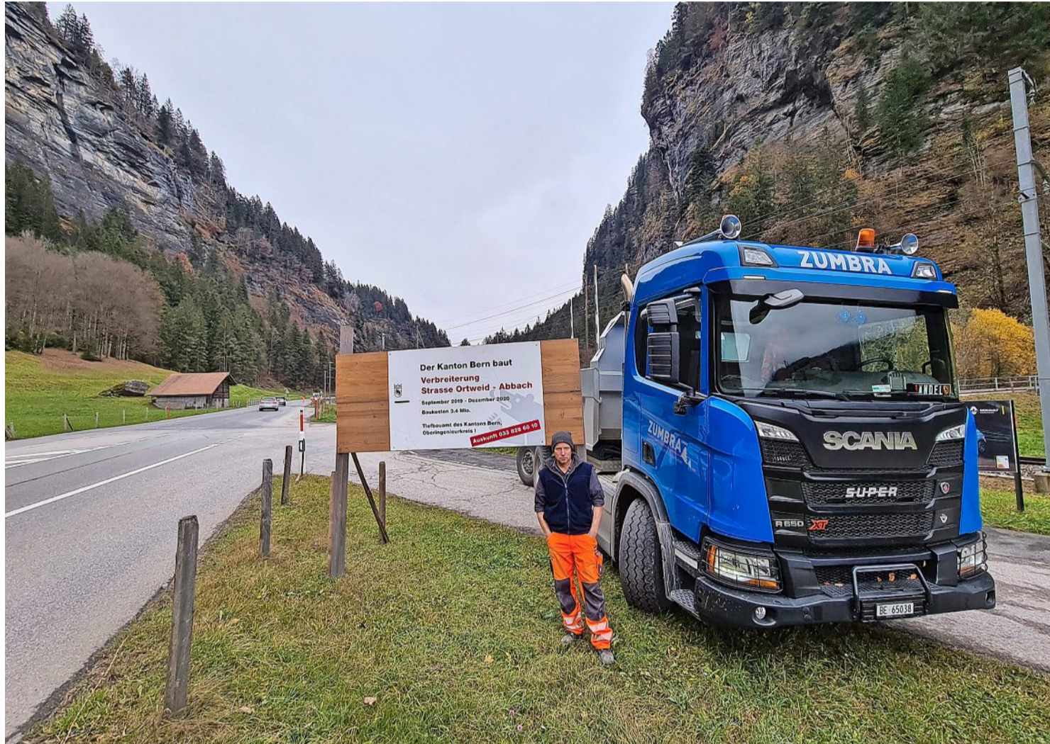
Deutlich früher als vom Kanton angegeben ist die Engstelle bei der Ortweid behoben. «E gröiti Sach», findet Christian Zumbrunn, Geschäftsführer der Zumbrunn Bau AG. Foto: Hans Peter Roth
