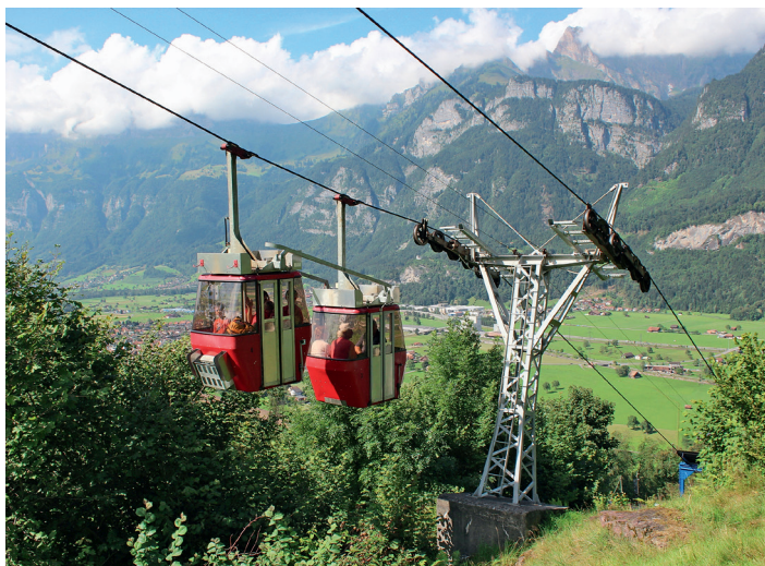
Ein Tandem der 4er-Kabine der Schönhaldenbahn mit Blick auf Flums.
