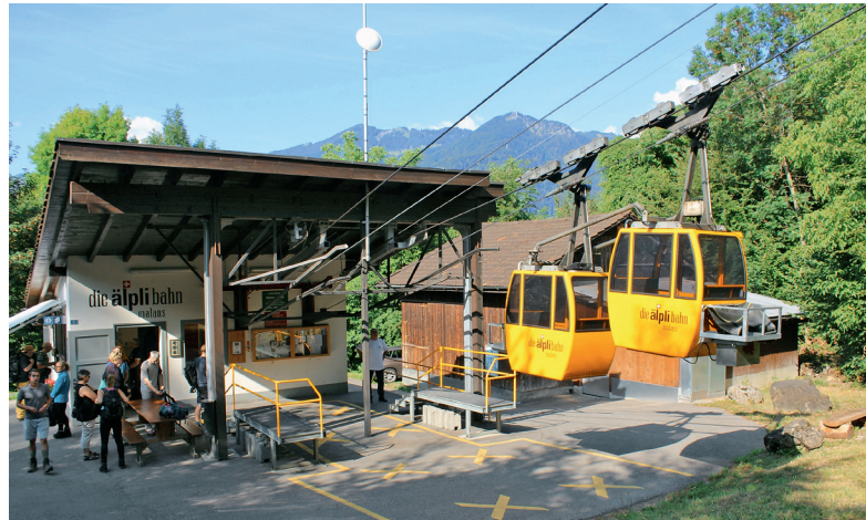
Talstation der Älplibahn in Malans mit dem Tandem von zwei 4er-Kabinen.
