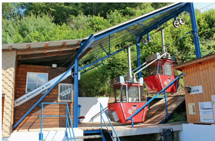
Die Talstation der Einseil-Gruppen-Pendelbahn Flums Saxli – Schönhalden wurde von der Firma Bartholet Maschinenbau AG im Jahr 2014 erneuert.
