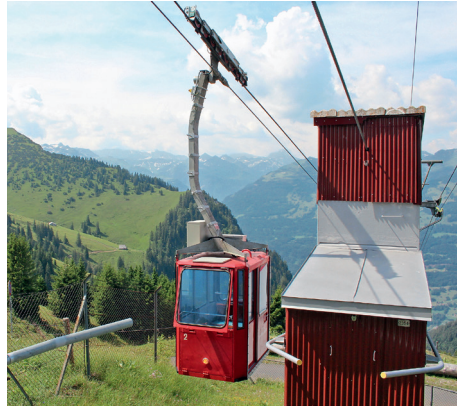
Das Zugseil der Palfriesbahn wird vor der Bergstation in einem separaten Spannturm gewichtsgespannt.
