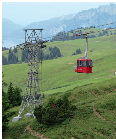
Die Kabine der Palfriesbahn bei der Bergstation.
