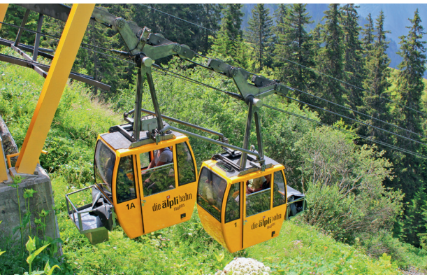
Die Älplibahn bei der Bergstation: Beide Kabinen sind mit zwei gelenkig befestigten Stangen verbunden, um einen konstanten Kabinenabstand zu gewährleisten.
