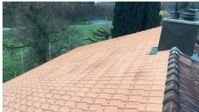
Sanierung einer Eternitfassade nach einem Sturmschaden.
