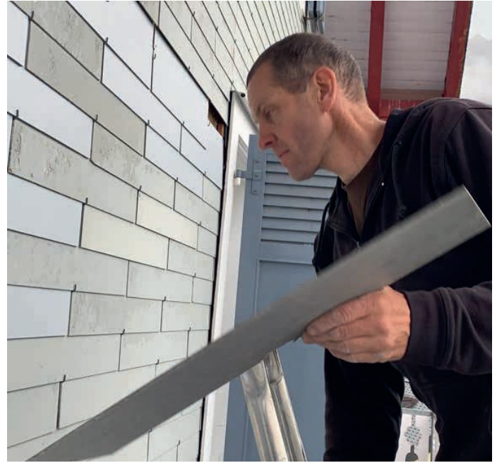
Sanierung einer Eternitfassade nach einem Sturmschaden.
