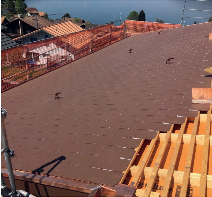
Sanierung einer Eternitfassade nach einem Sturmschaden.
