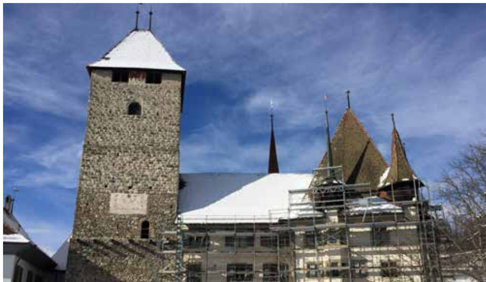
Das Baugerüst wird gestellt (Januar 2021)
