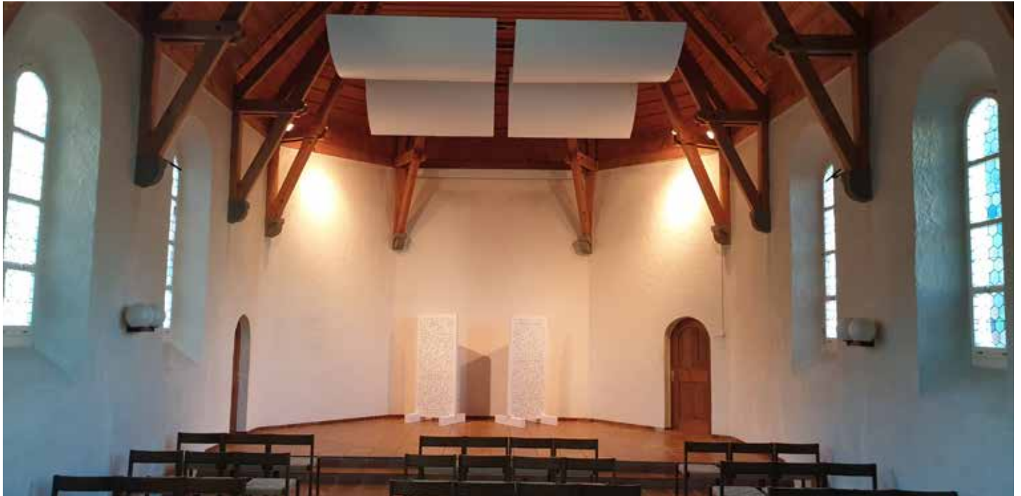
Vier gekrümmte Panels an der Decke, zwei senkrechte Schallabsorber im Chorbereich und eine kleine Verstärkeranlage optimieren den Klang in der KulturKapelle9.
