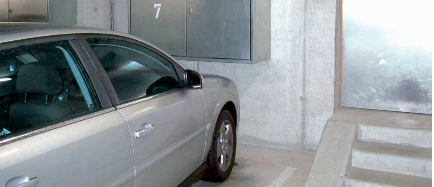
Gutes Beispiel einer Einstellhalle: freie Fluchtwege, keine brandgefährlichen Materiallager.
