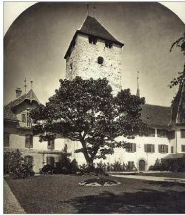
Der Schlosshof um 1900. Die im Turm sichtbaren Risse wurden später mit weither sichtbaren Eisenspangen stabilisiert.
