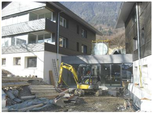
Die Bauarbeiten für den Garten der Demenzwohngruppe sind in vollem Gang. In den Obergeschossen entstehen Alterswohnungen. (Zwei Wohnungen sind noch frei.)
