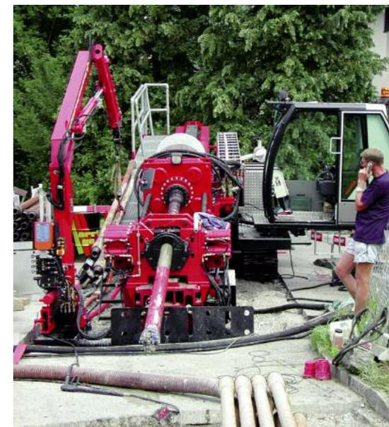
Bohrmaschine mit Felsbohrkopf
