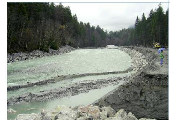
Die fertiggestellte Blockrampe im «Betrieb». Im Bildvordergrund Bau einer neuen Blockbuhne zur Sicherung der Blockrampe.
