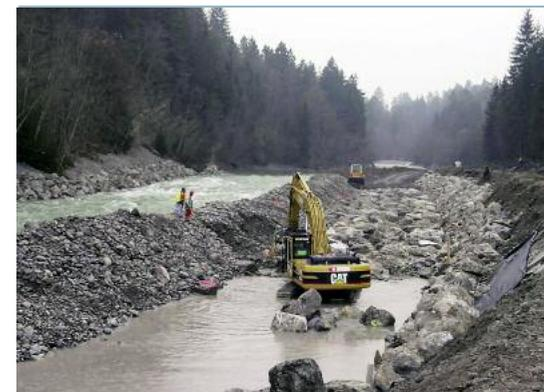
Bau der Blockrampe auf Seite Reutigen: Die Kander wird über die rechtsufrig fertiggestellte Blockrampe geleitet (links im Bild).
