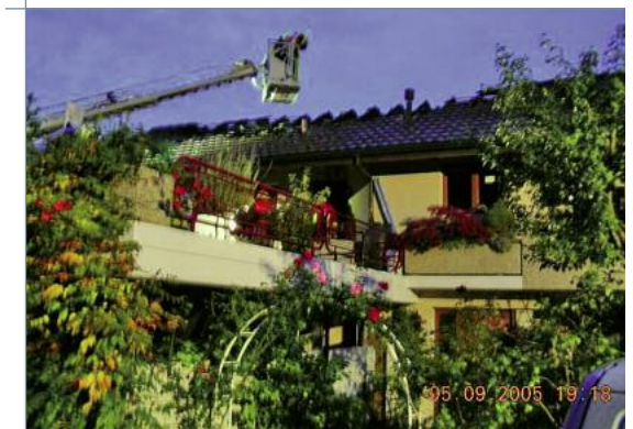
Dachstockbrand am Rosenweg, Gwatt
