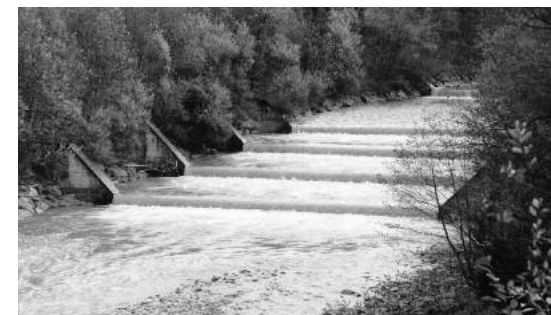
Die Zwischenräume der vier Sperren werden mit Blöcken aufgeschüttet.
