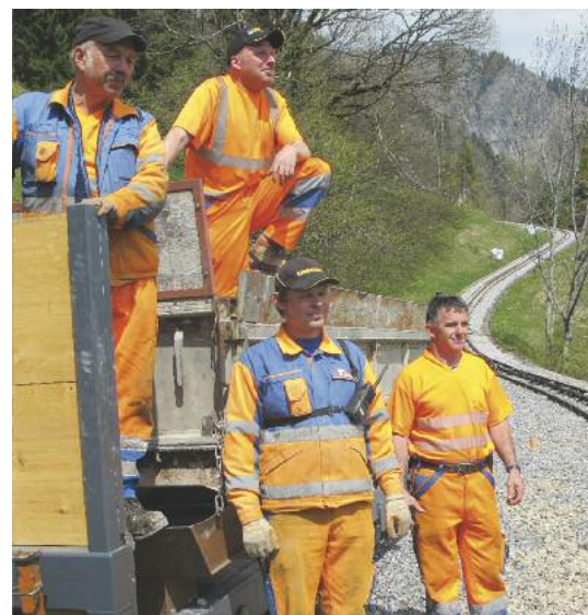
Hanspeter Dütsch und sein Team mit dem Bauzug an der Baustelle Geldried. Im Hintergrund die Maximalsteigung von 250 Promillen.
