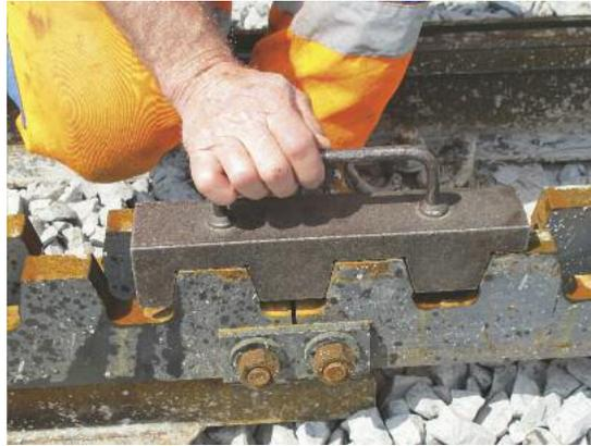
Die Zahnstangen werden auf den Millimeter genau zusammengefügt.
