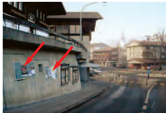
Seestrasse, Kronenplatz, an Stützmauer
