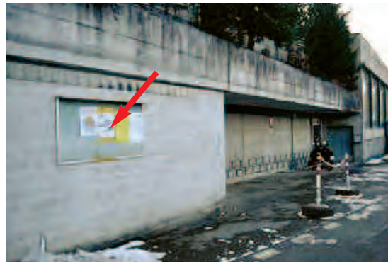
Höhenstrasse, an Mauer beim Schulhaus Roggern
