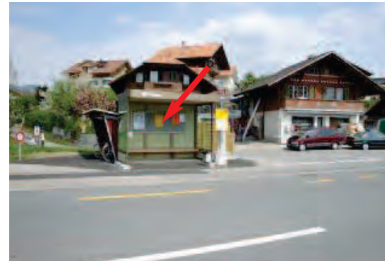
Thunstrasse, in Bushaltestelle Einmündung Werkstrasse
