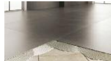
Verlegen auf einen alten Fliesenbelag
