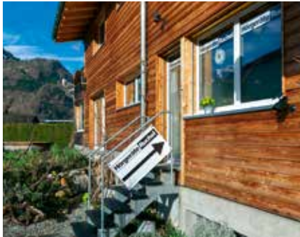
Herzlich Willkommen! Der Geschäftseingang in Matten bei Interlaken am Nelkenweg 11.
