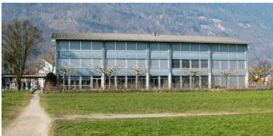
Schulhaus Chabismoos in Matten: Das Dach für die Photovoltaikanlage.
