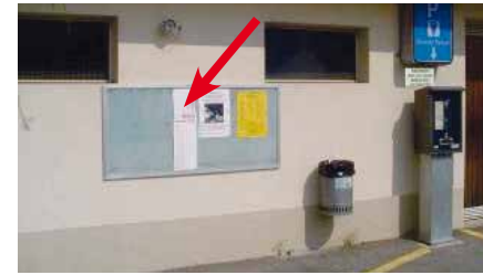
Gebäude Pumpwerk, Parkplatz Dorf (Tenne)
