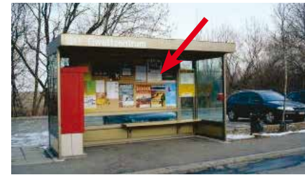
Spiezstrasse, Bushaltestelle Gwatt-Zentrum, (seeseitig)
