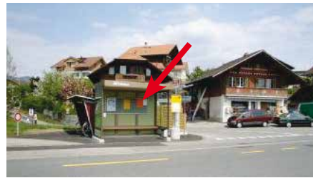
Thunstrasse, in Bushaltestelle, Einmündung Werkstrasse
