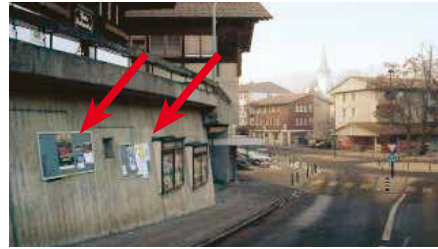
Seestrasse, Kronenplatz, an Stützmauer
