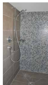
Dusche mit Ablauf in der Mitte
