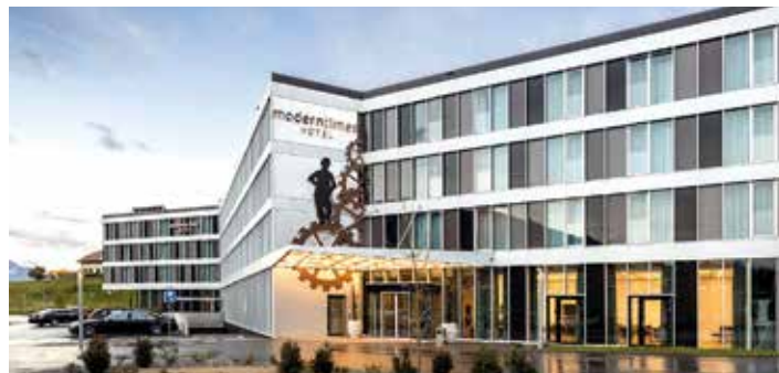
HOTEL «MODERN TIMES» OBERHALB VEVEY. DAS ZUM CHARLIE CHAPLIN-MUSEUM «CHAPLINS WORLD» NEU ERSTELLTE HOTEL. KOMPLETTE GASTRO-EINRICHTUNG INKL. GRILL, BAR UND KÜCHE.
