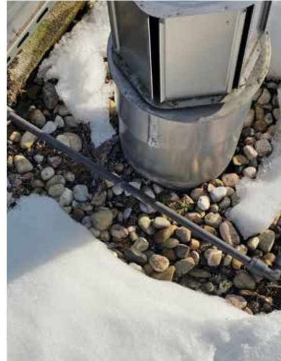
Thermische Solaranlage 25 m 2 . Einsparung durch Weglassen Dämmung CHF 1400.–. Geringere Solarernte in 25 Jahren CHF 1900.–
