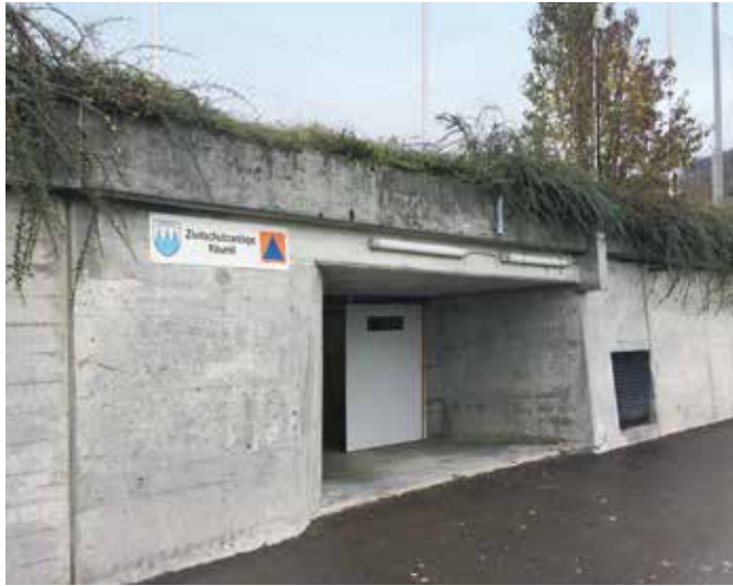
Der Kommandoposten der Gemeindeführungsorganisation befindet sich in der Zivilschutzanlage Räumli. Ausserlich ist von der Sanierung nichts feststellbar.
