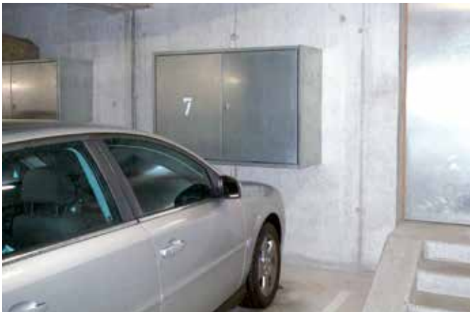
Gutes Beispiel einer Einstellhalle: freie Fluchtwege, keine brandgefährlichen Materiallager.
