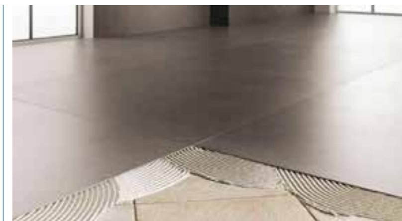
Verlegen auf einen alten Fliesenbelag
