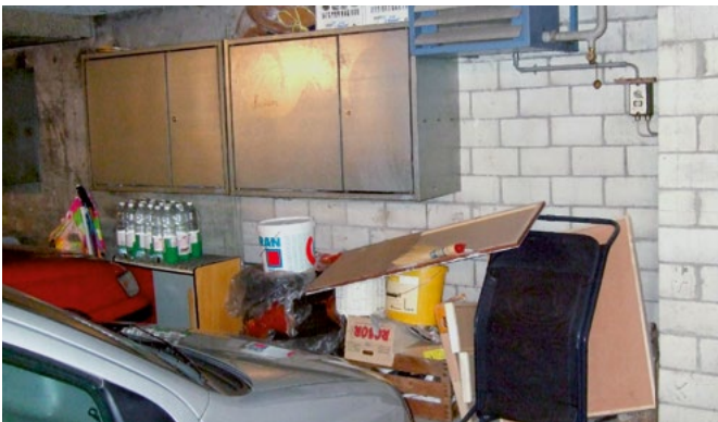
Schlechtes Beispiel einer Einstellhalle: versperrte Fluchtwege, gelagerte Materialien, welche die Brandgefahr erhöhen.
