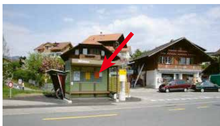
Thunstrasse, in Bushaltestelle, Einmündung Werkstrasse
