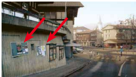
Seestrasse, Kronenplatz, an Stützmauer
