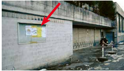
Höhenstrasse, an Mauer beim Schulhaus Roggern
