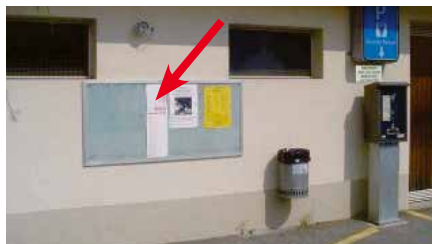
Gebäude Pumpwerk, Parkplatz Dorf (Tenne)
