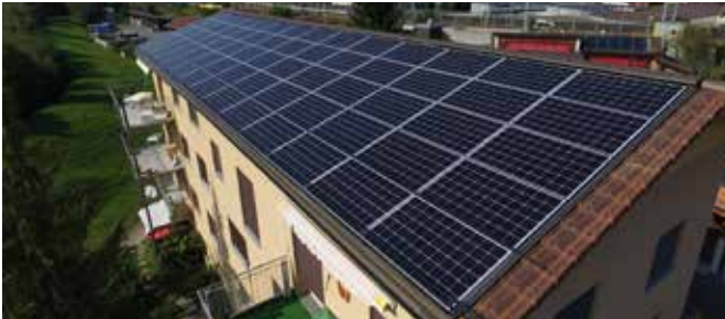
Dachsanierung und Umstellung auf Eigenverbrauchsgemeinschaft MFH Simmentalstrasse 8 in Spiez
